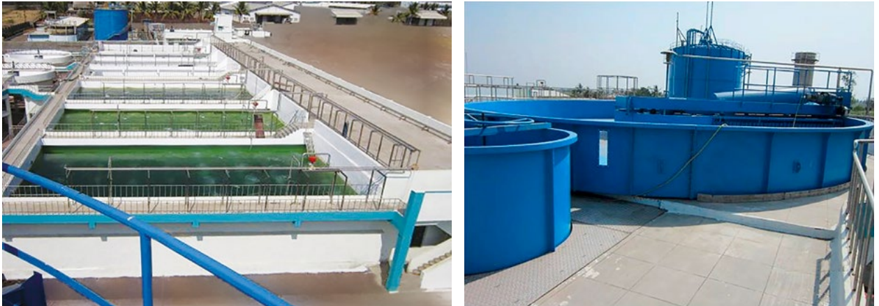
Figure 2 : Installation pour l'usine laitière de Chitale à Bhilwadi, Maharashtra, Inde
