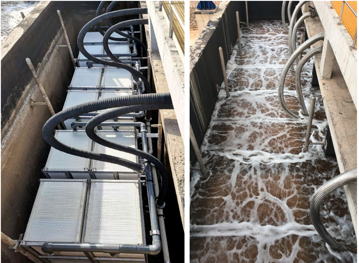
Figure 1 : Modules membranaires immergés après installation (gauche) et en fonctionnement (droite)
