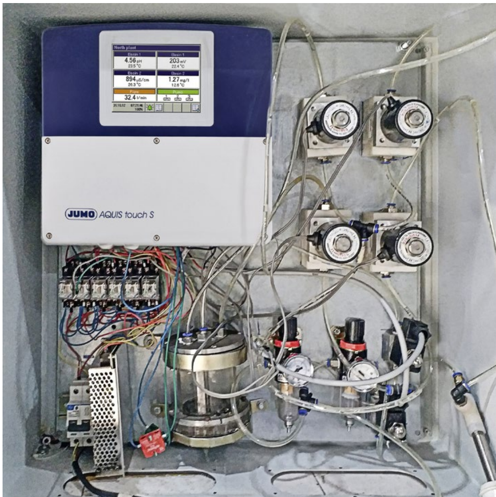
Figure 2 : appareil de mesure multicanal modulaire avec régulateur intégré et enregistreur sans papier JUMO AQUIS touch S
