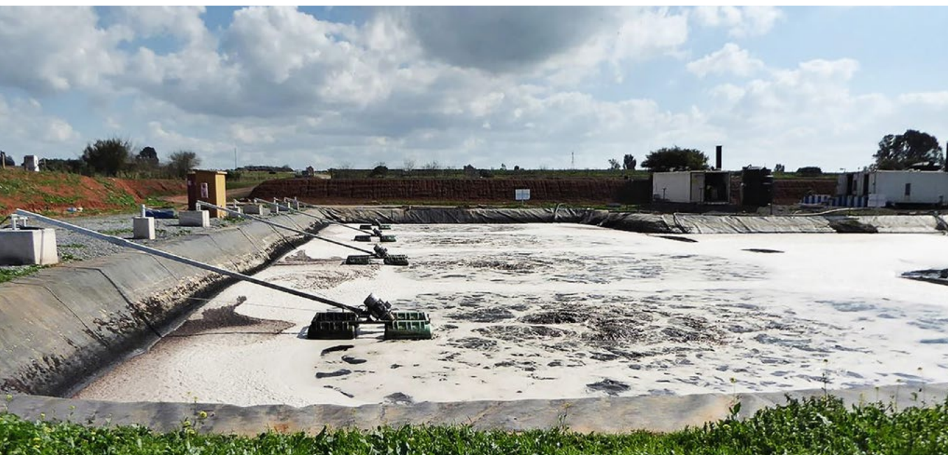
Figure 1 : Passage à des aérateurs OxyStar dans la station de traitement des eaux d'infiltration d'Oum Azza, Maroc
